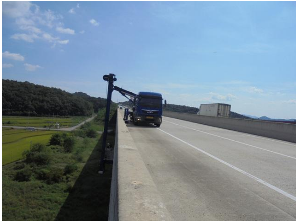
교량점검차를 이용한 근접조사
