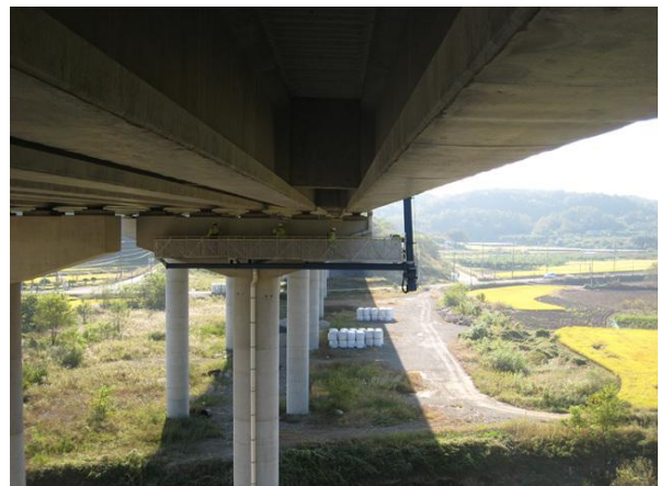
교량점검차를 이용한 근접조사
